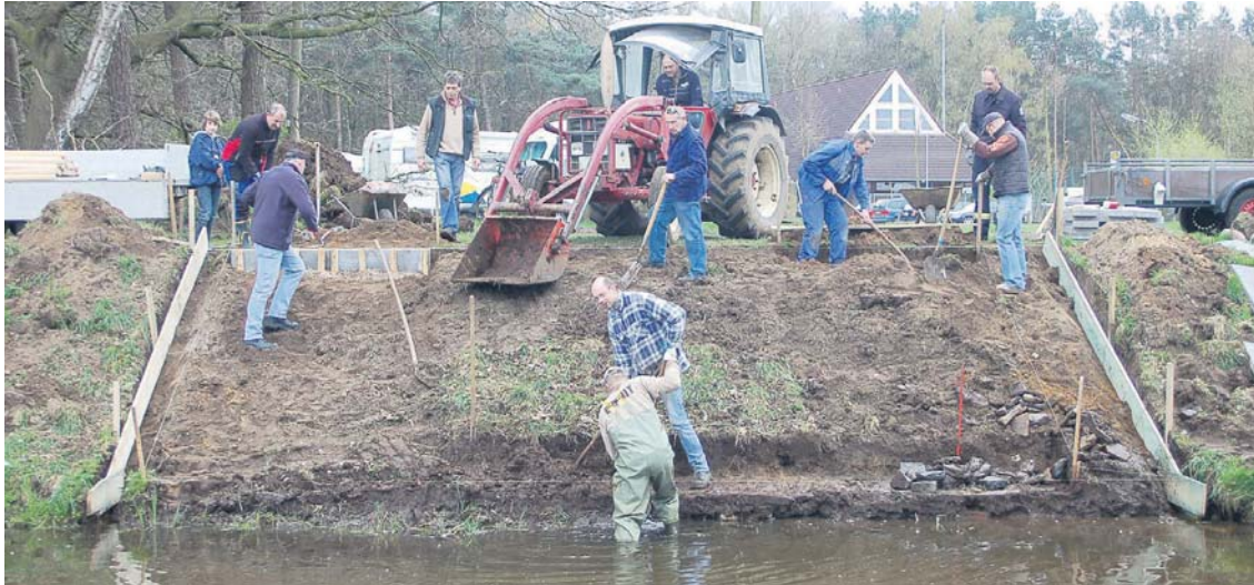
Am Samstagmorgen begannen die freiwilligen Helfer mit den Arbeiten zum Bau einer Anlegestelle. DZ-Fotos: Claudia Marcy
